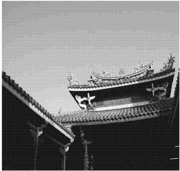
圖十一 第二進為等級較高的 歇山重簷式架構
