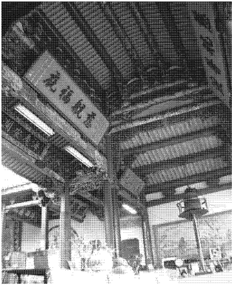
圖十 拜殿內高大壯闊的 捲棚式木構屋架
