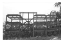
持戒、修定，必依「正見」；猶如造屋，先建棟梁。 （香光山工地，Jeremy 攝）
