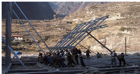
⑤ 現場居民組裝鋼構，團隊技術指導
