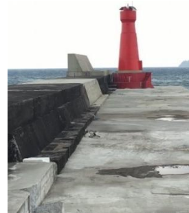
北外廓防波堤現況
