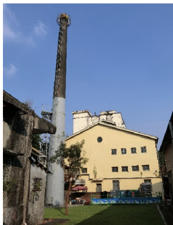
圖 13 屏東菸葉廠的鍋爐室外觀及煙囪 (2019 年拍攝)
