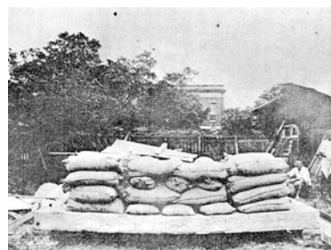
圖 9 中空鋼筋混凝土構造強度實驗 （出處同左）
