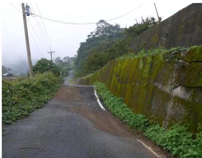
圖 7 根據室內判釋結果，實際赴現場找尋可能的地形特徵證據，此為圖 6(A)處於現地上出現崩崖切過路面，呈現明顯的落差與擋土牆破壞的情況
