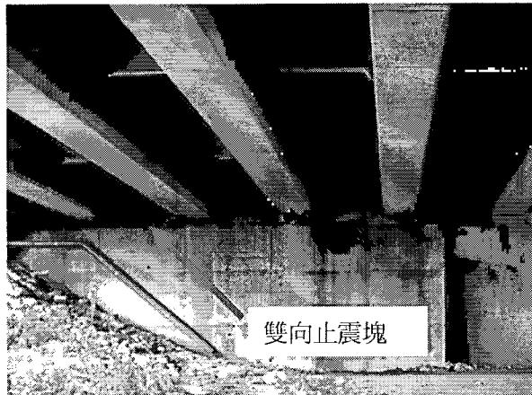
圖 2 傳統 PCI 簡支大梁之合成橡膠支承墊與混凝土雙向止震塊佈置圖
